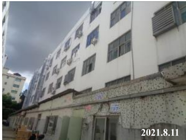
项目西南面工业厂房
