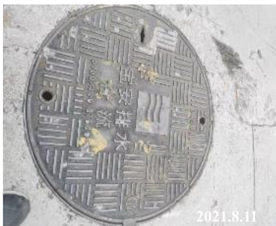
项目所在地污水井盖
