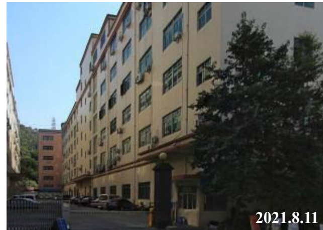
项目东南面工业厂房
