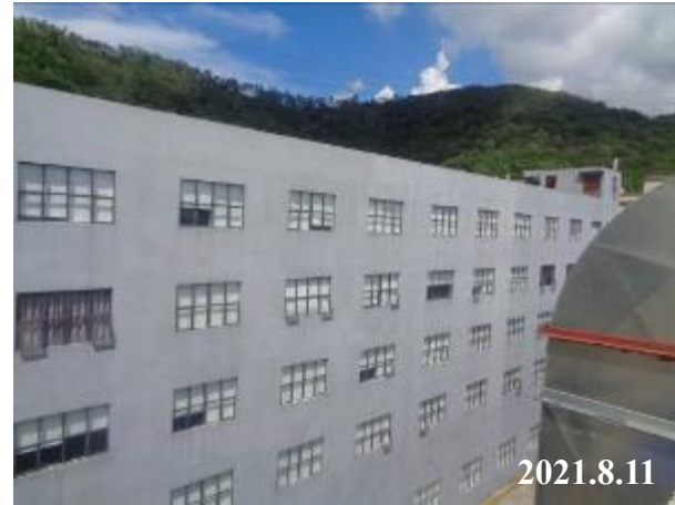
项目东北面工业厂房
