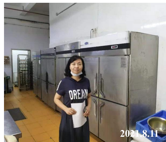
工程师现场勘察图片②
