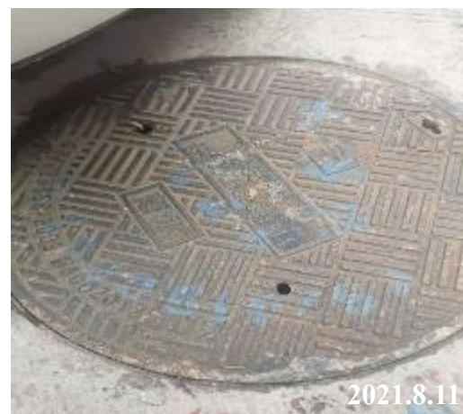
项目所在地雨水井盖
